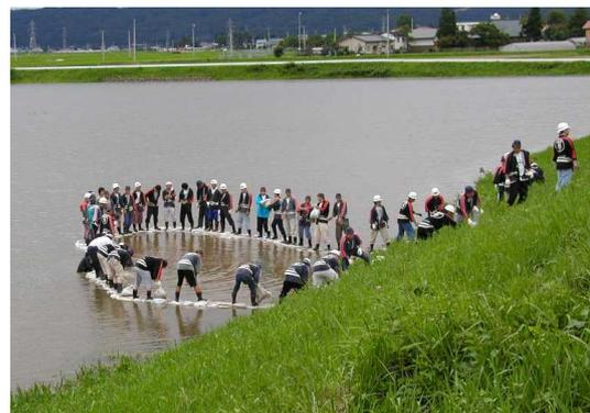
写真-3.1 堤防の基盤漏水（会津坂下町）
