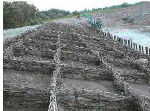
写真-7.4 自然河岸をつくり出す水制工
