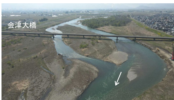
写真1.1 会津大橋付近(阿賀川17k~18k)
