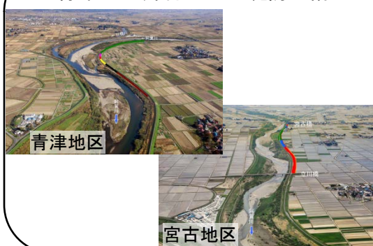
青津地区、宮古地区 堤防整備
