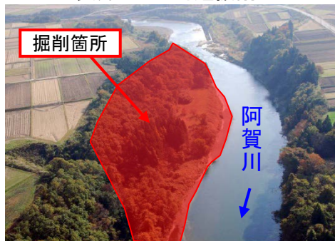
長井地区 河道掘削
