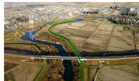
浜崎地区浸透対策
