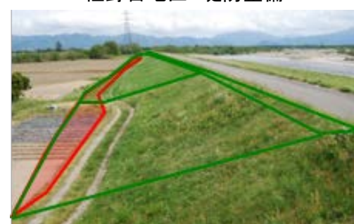
佐野目地区 堤防整備
