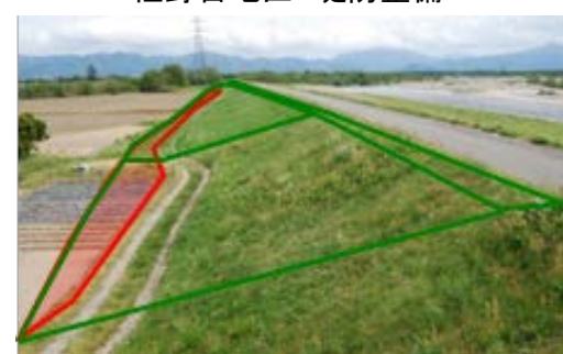
佐野目地区 堤防整備
