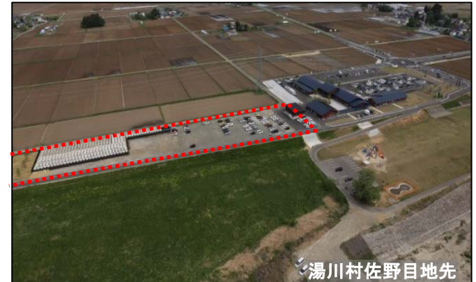
阿賀川佐野目防災ステーション
