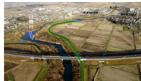
浜崎地区浸透対策
