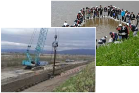
青津地区 堤防浸透対策
