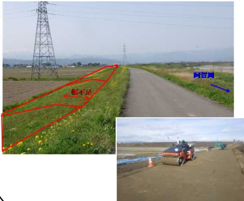
宮古地区 堤防整備
