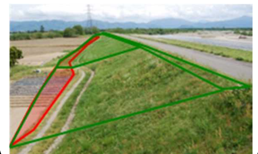
佐野目地区 堤防整備
