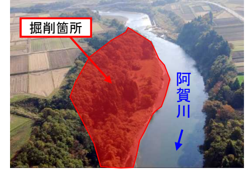
長井地区 河道掘削
