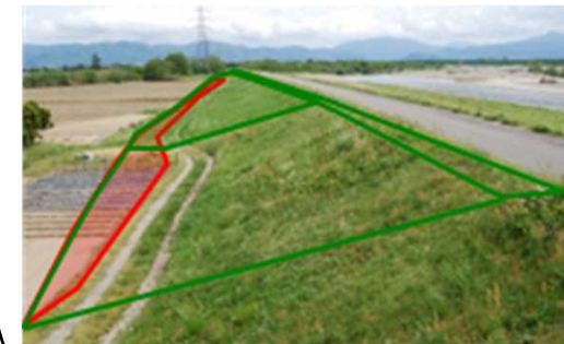
佐野目地区 堤防整備
