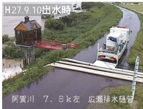
【排水ポンプ車】
