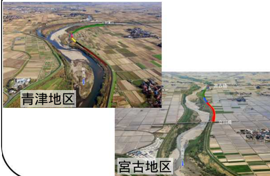
青津地区、宮古地区 堤防整備
