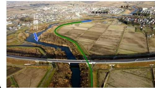
浜崎地区浸透対策
