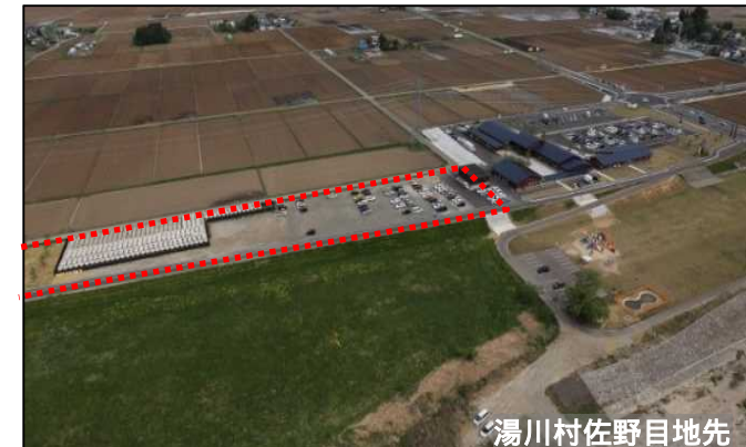
阿賀川佐野目防災ステーション
