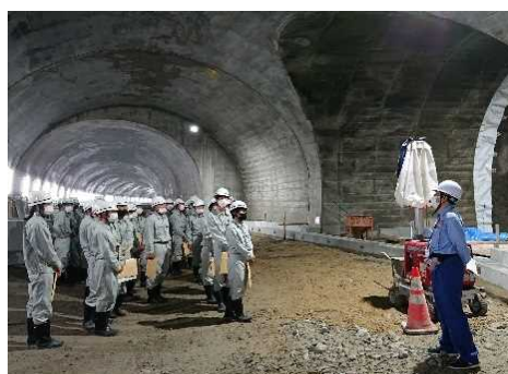
利賀トンネル施工状況の説明
