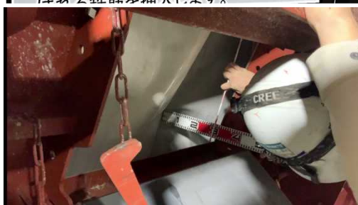
↑ 利賀トンネル工事施工説明 ← 遠隔臨場(トンネル覆工) のデモ説明 (株)安藤ハザマ
