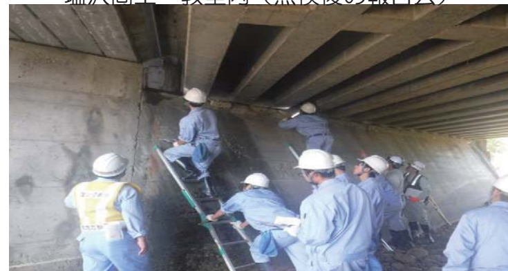
国道17号 伊田川橋(打音検査で浮きの有無を確認)
