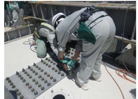
橋梁の高力ボルトの締め付け体験
