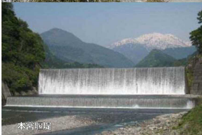
常願寺川沿岸用水 左岸連絡水路橋
