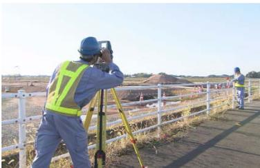
測量の現場では、いろいろな測量機器を使って、土地の距離・角度・高低差などを正確に測って土地の形状を表す「地形図」を作成します。
