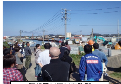
阿賀野川河川事務所 阿賀野川河口耐震対策工事
