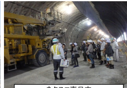
ネクスコ東日本 磐越自動車道 吉津トンネル工事
