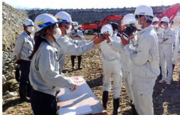
[VR(仮想現実)による工事施工体験]
