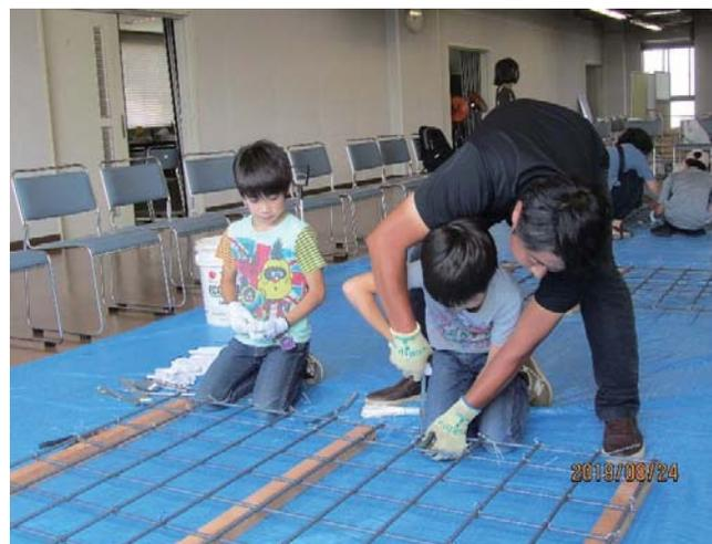
ハッカーというくぎ抜きに似た器具や自動結束機を使って鉄筋同士の交差部に針金を巻き付けて結束する作業を体験(約80名が体験)
