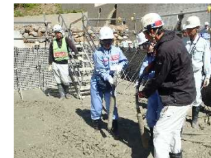
コンクリート打設体験
