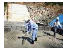
コンクリート打設体験
