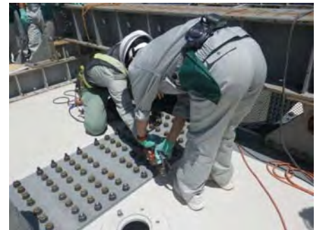
橋梁の高力ボルトの締め付け体験
