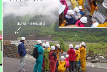
砂防堰堤の見学
