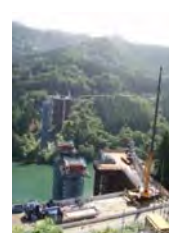
見学当日の施工状況 (庄川橋梁上部工事)
