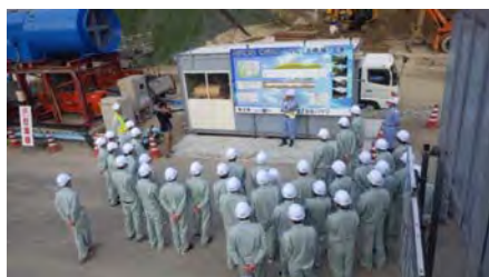
工事概要の説明
