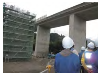
1期線と沿う五十母川橋の橋脚の施工状況
