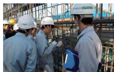
鉄筋の結束作業
