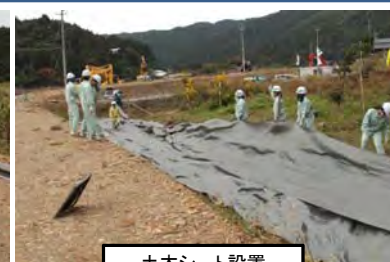
土木シート設置
