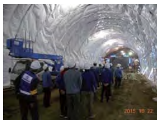
トンネル坑内の施工状況
