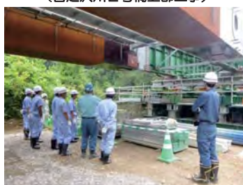
○送り出しによる架設現場の見学 (庄之又川7号橋上部工事)
