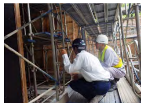
施工状況見学
