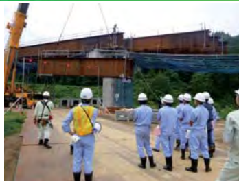
○大型クレーンによる架設現場の見学 (岩之沢川2号橋上部工事)
