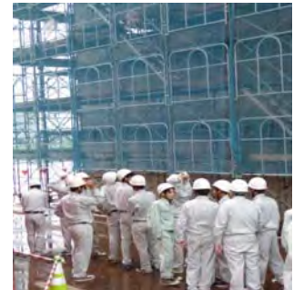
ケーソン製作を間近で視察
