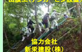
山腹工(アンカーピン設置)
