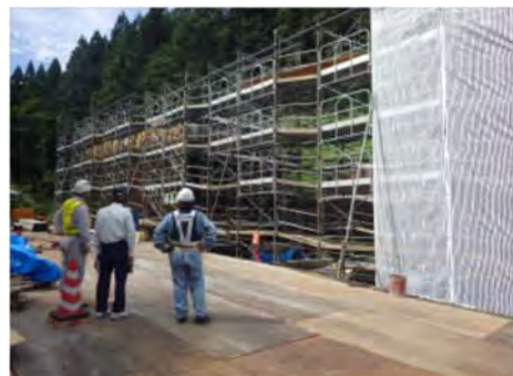
施工状況見学
