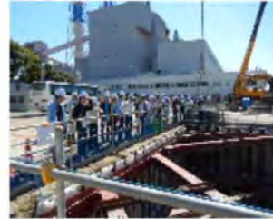
山留工保工の説明を受ける学生
