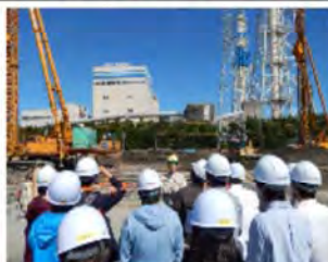
基礎工事見学状況
