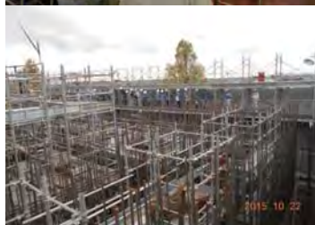
ポンプ場構築状況を足場上から見学
