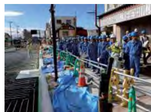
街路工事の現場
