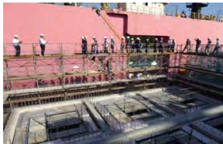
ケーソン製作の足場にとって間近で視察
