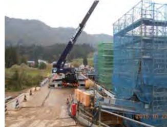
五十母川橋の橋脚の施工状況
