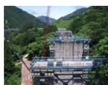
見学当日の施工状況 (豆谷橋梁上部工事)
