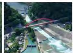
愛本床止工・堰堤
