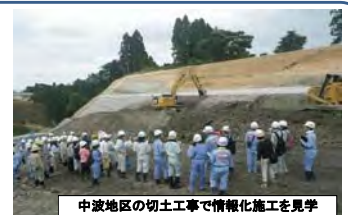
中波地区の切土工事で情報化施工を見学
