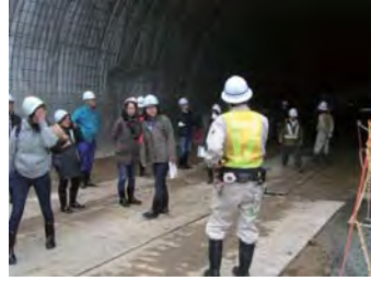
○ネクスコ東日本 磐越自動車道 吉津トンネル工事
