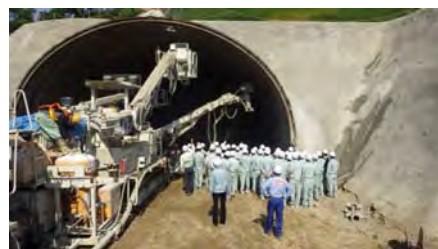
施工状況の見学
