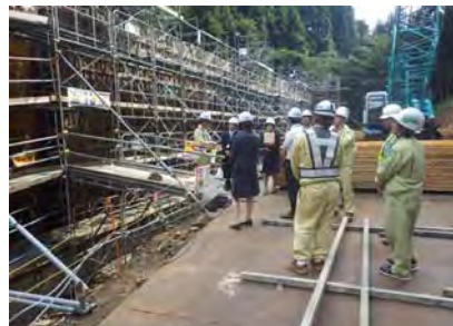
現場説明(中道路)
