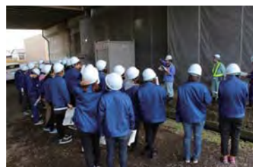
橋梁補修工事の現場見学
