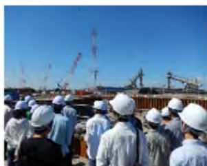
仮設工事状況を見学
