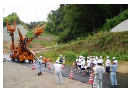
トンネル施工機械(削孔マシン)を稼働し、説明
