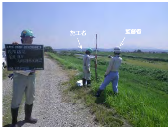
工事測量の現地確認状況
