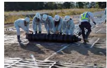
ジオテキスタイルの敷設
