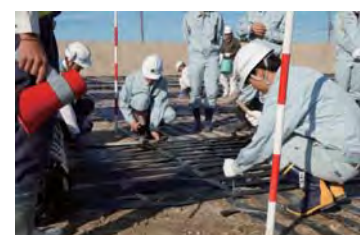
ジオテキスタイルの固定作業
