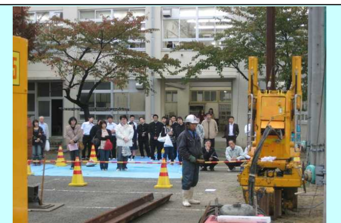
■鋼矢板打込実演：1回目11時約50名 サイレントパイラーにより鋼矢板2枚打込
