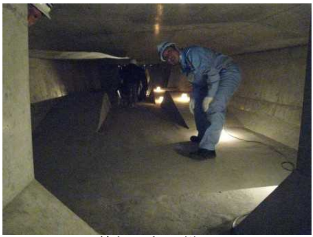
箱桁内部の様子
