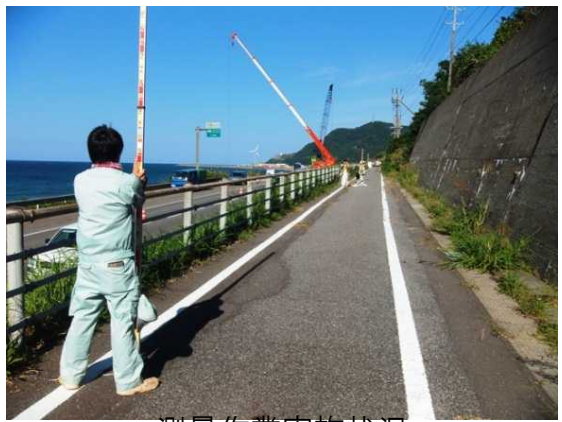
測量作業実施状況 (国道8号久比岐自転車道)
