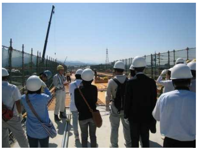
鉄筋組立作業の説明を受ける様子
