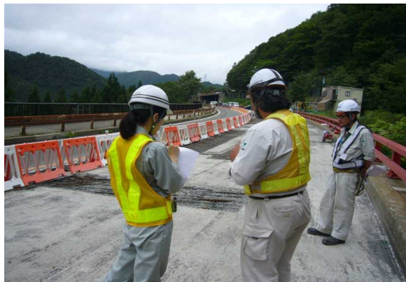
長岡国道事務所 橋梁補修現場での実習
