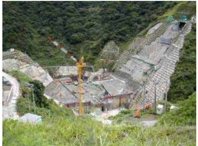
広神ダムの建設状況
