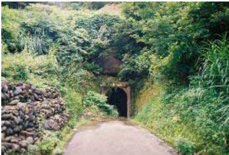
中山隧道坑口（魚沼市側）
