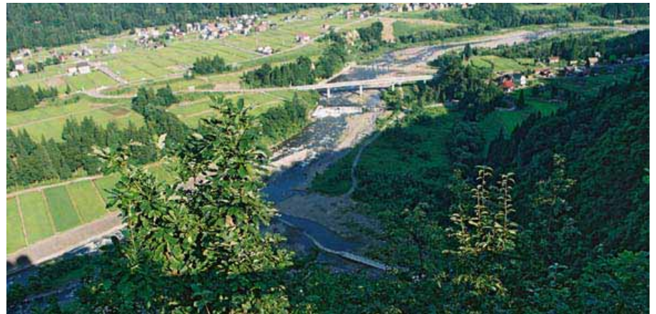
現在の石坂橋付近（橋の上流が第 3 号床固工、中央部手前に白く見えるのが第 4 号床固工）
