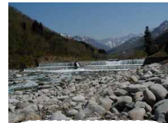
整備が進む第4床固工
