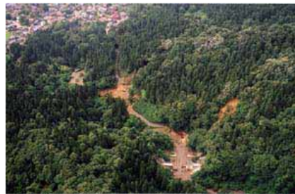
長岡市加津保町の土石流
