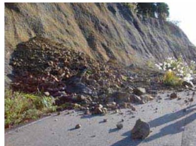
長岡市（旧山古志村の崖崩れ）
