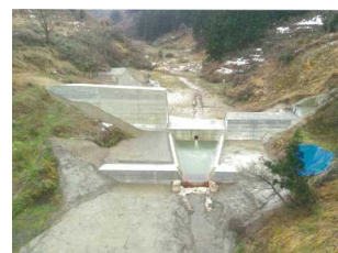
源太山川砂防堰堤その2工事 施工：株式会社 多田組
