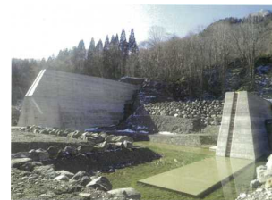
中津川上流第1号堰堤砂防その6工事 施工：株式会社 フクザワコーポレーション
