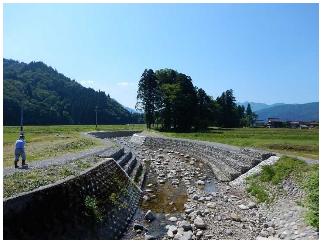
湯沢砂防が施工した溪流保全工
