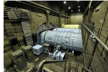
関越トンネル 谷川地下換気所
