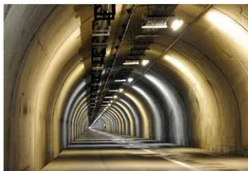
関越トンネル 避難坑
