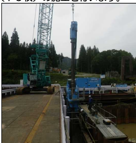
クラッシュパイラー施工状況
