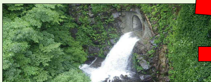
トンネル吐口放流状況
