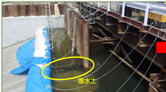
鋼矢板水中切断状況
