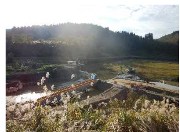
完成間近の竜光魚道工
