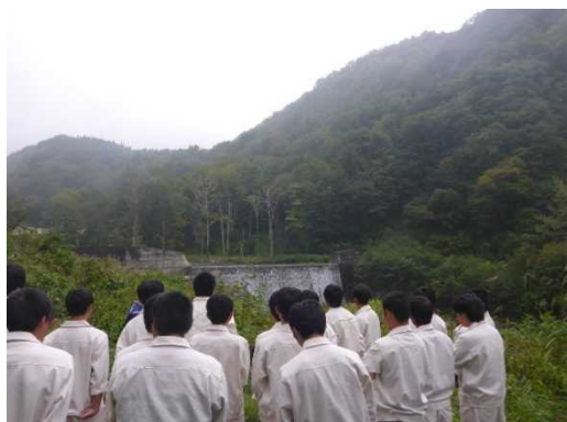
上野原第2号砂防堰堤を見学
