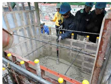
コンクリートの打設体験
