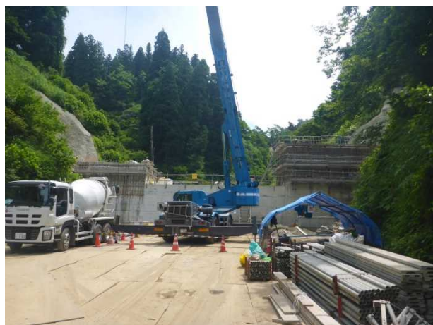
工事が進む「冷子沢第3号砂防堰堤」
