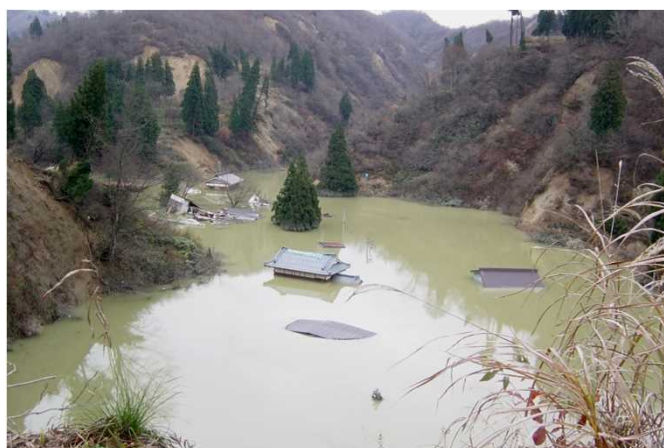
大規模な河道閉塞が発生した東竹沢地区および木籠集落(H16.11月撮影)
