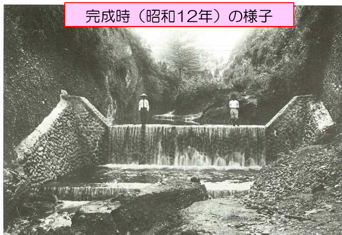
湯沢砂防工場完成1号 辻又川砂防ダム (昭和12年9月14日完成) ダム規模H: 3.0m L: 13.0m V: 63m 3 副ダム水叩 総立浸142m 3
