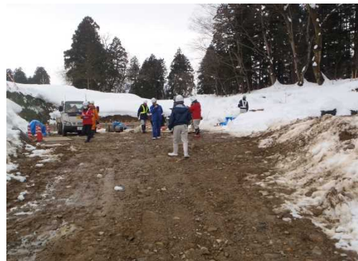
高棚川溪流保全工工事 パトロール状況
