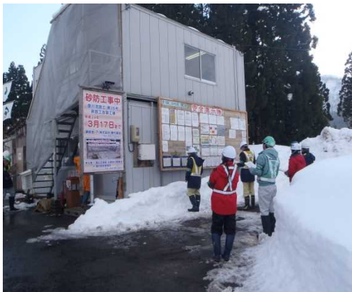
登川流路工第28号床固工改築工事 工事掲示板 確認
