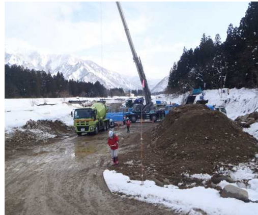
登川流路工第28号床固工改築工事 パトロール状況
