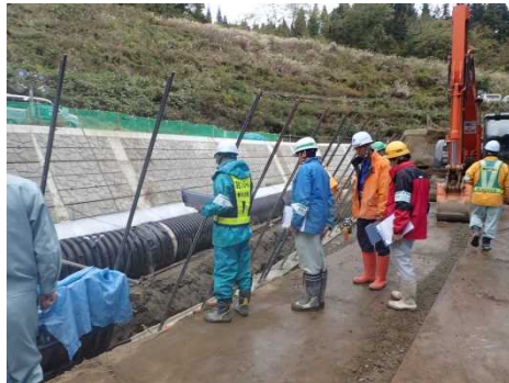
パトロール状況② 相川川上流第2号砂防堰堤外工事
