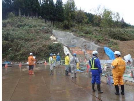
パトロール状況② 源太山川砂防堰堤工事
