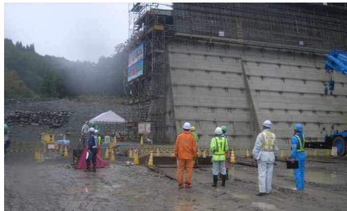
中津川上流第1号砂防堰堤その5工事 パトロール状況
