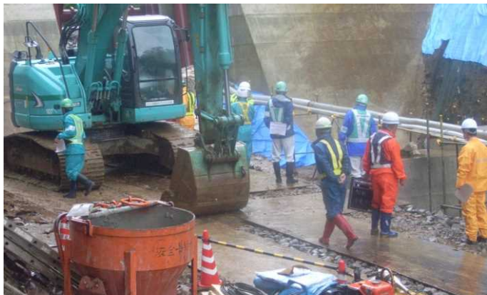
石黒川第2号砂防堰堤その3工事 パトロール状況
