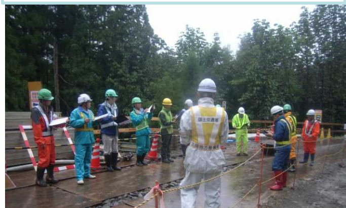
石黒川第2号砂防堰堤その3工事 反省会(報告会)
