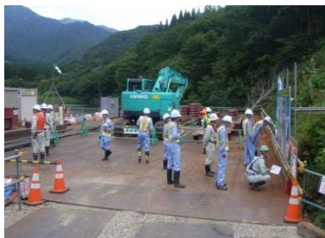
大源太川第1号砂防堰堤補強工事 パトロール状況
