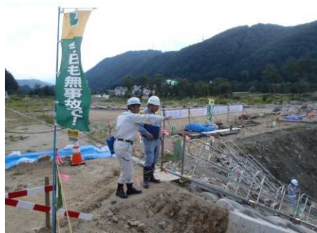
三俣溪流保全工その3工事 パトロール状況
