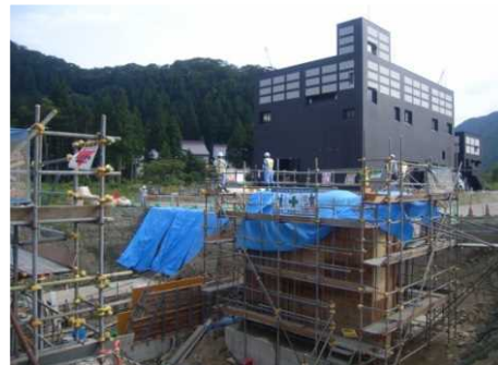
浅貝第1号砂防堰堤工事(八木沢工区) パトロール状況
