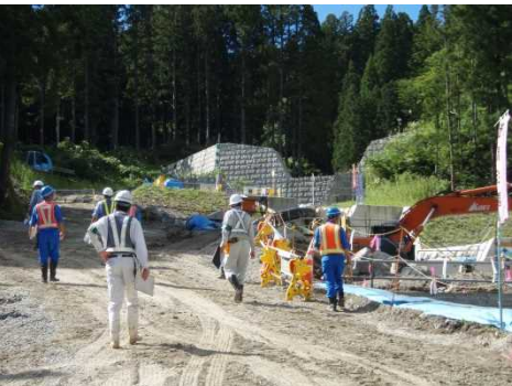
高平沢溪流保全工他工事 パトロール状況
