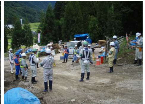
高平沢溪流保全工他工事 意見交換
