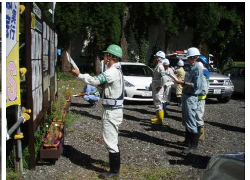
高平沢溪流保全工他工事 掲示板確認
