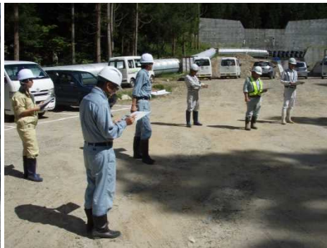
蛭窪溪流保全工工事 意見交換
