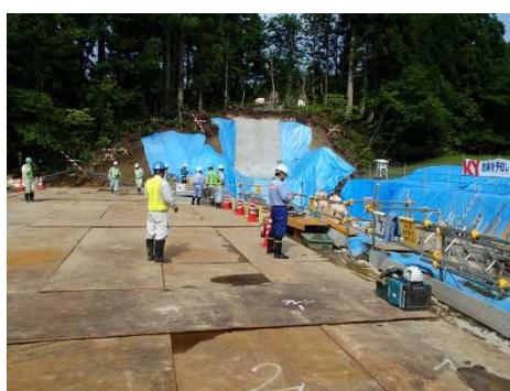
大形砂防堰堤工事 パトロール状況
