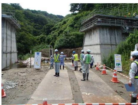
向山第1号砂防堰堤その2工事 パトロール状況
