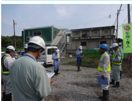
大形砂防堰堤工事 意見交換
