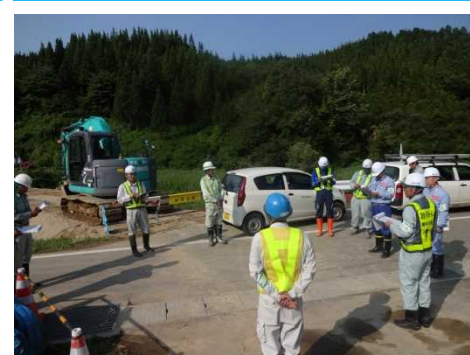
源太山川砂防堰堤工事 意見交換
