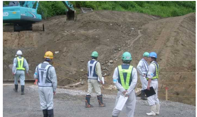
上塩谷地区地すべり対策その5工事 パトロール状況
