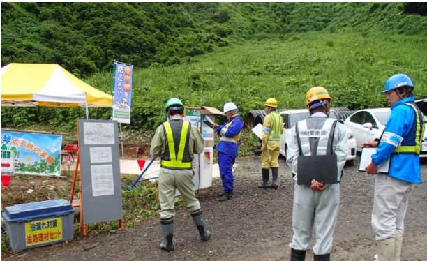
池谷地区地すべり対策工事 パトロール状況
