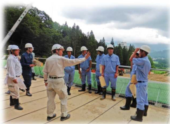
建設系学生向け現場見学会の様子 (7/14 戸沢入川砂防堰堤)
