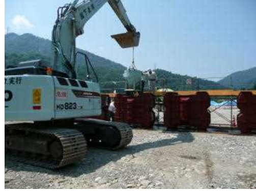
平成28年度の工事が始動
