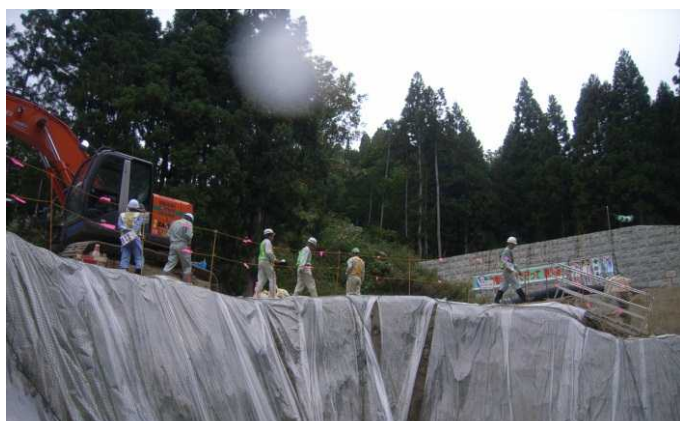
高平沢溪流保全工(上流部)工事 パトロール状況
