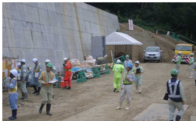
土沢第1号砂防堰堤その4工事 パトロール状況
