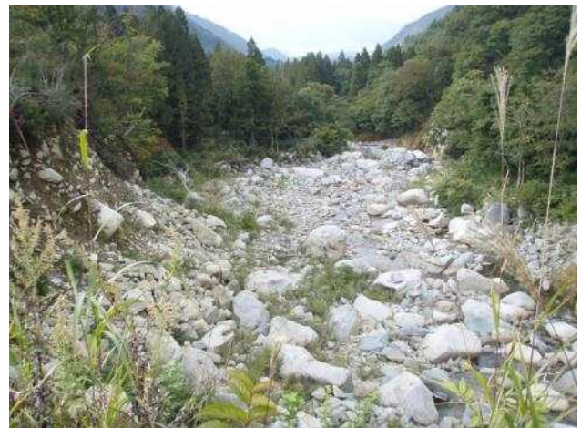
二子沢の状況を確認
