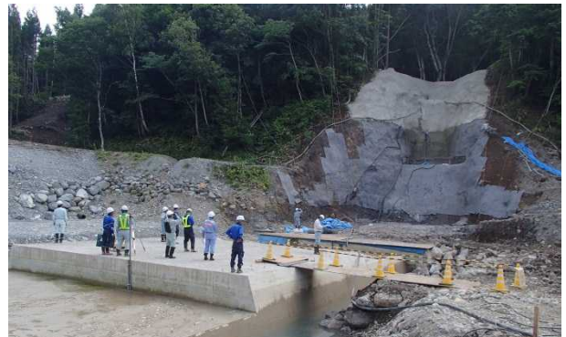
中津川上流第1号砂防堰堤その4工事 掘削箇所点検状況
