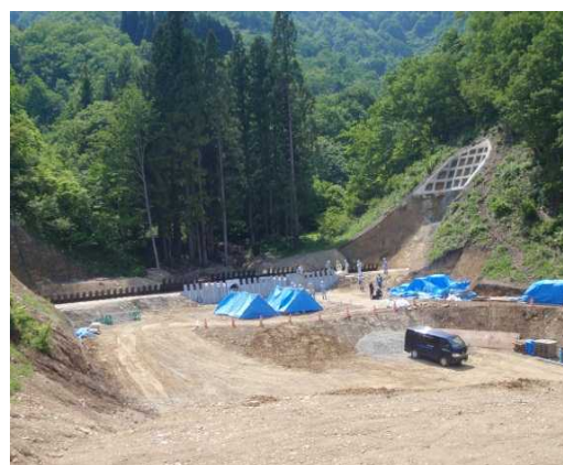
戸沢入川砂防堰堤他工事点検状況
