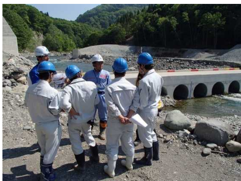
中津川上流第1号砂防堰堤見学
