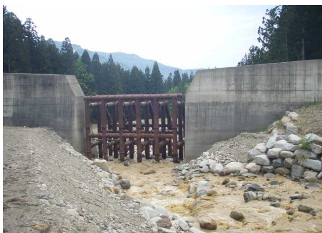
姥沢川第2号砂防堰堤の状況 姥沢川流域(中流部)
