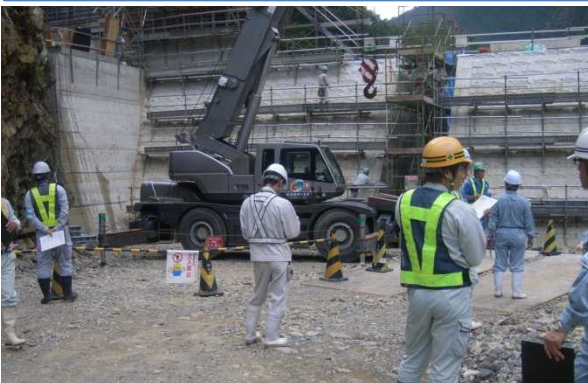
高石上流第2号砂防堰堤その2工事パトロール状況
