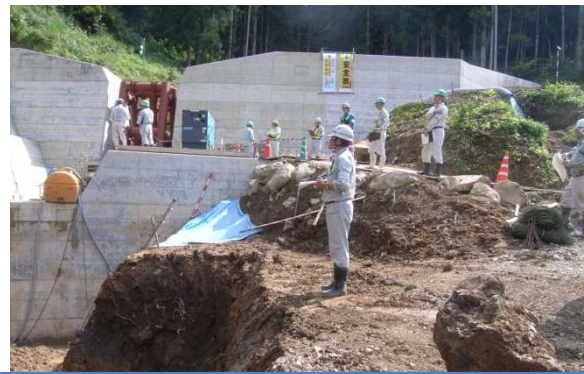
大倉砂防堰堤その2工事 パトロール状況
