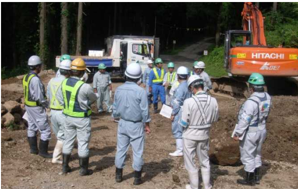
大倉砂防堰堤その2工事 工事説明
