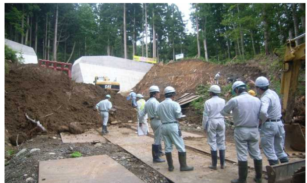
石黒川砂防堰堤群工事 パトロール状況
