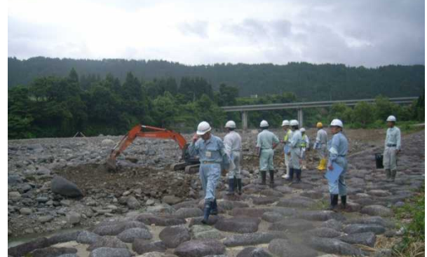
中津川床固工群補強工事パトロール状況
