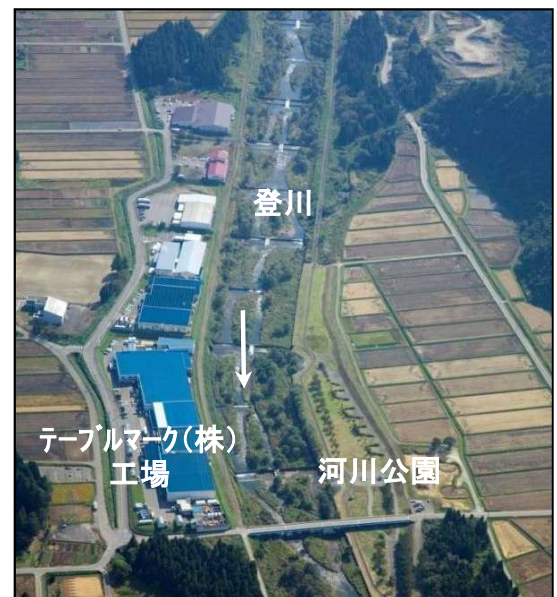
登川流路工 施工後の状況
