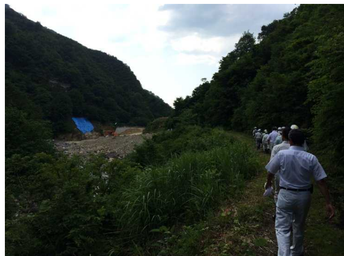
奥に見えるのが高石上流第2号砂防堰堤の建設現場です。
