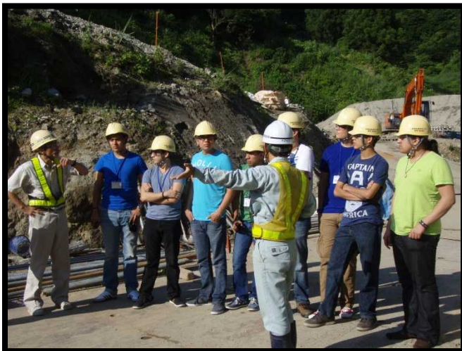
砂防堰堤工事の施工手順を説明
