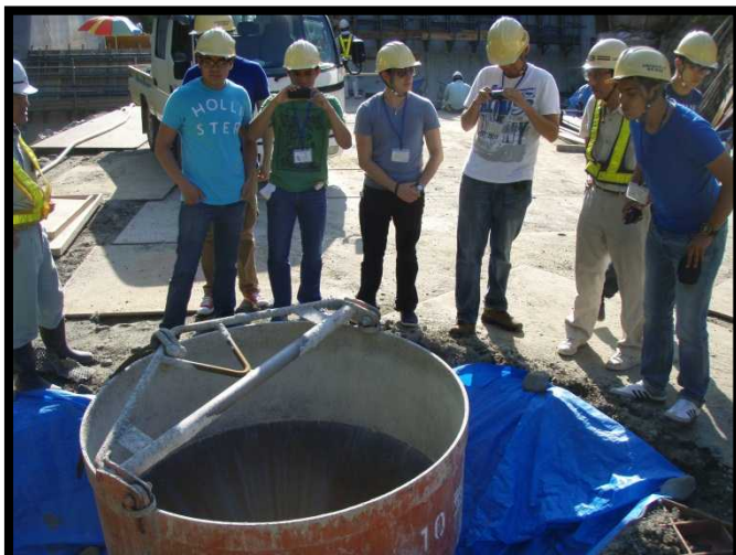
生コンクリート打設ホッパーに皆さん興味津々
